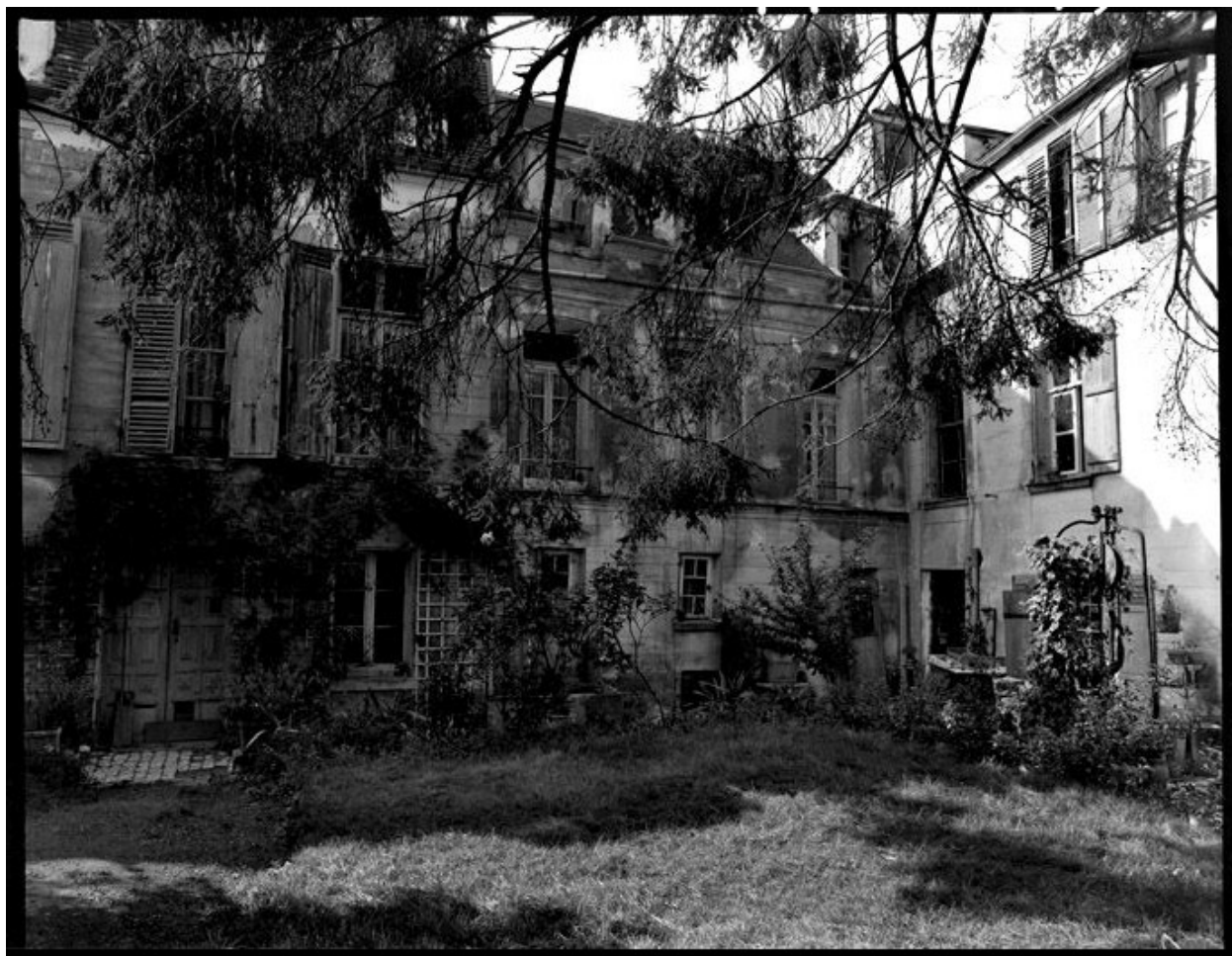
Maison, Abbé-Hua (rue de l') 10. Vue de la cour.
