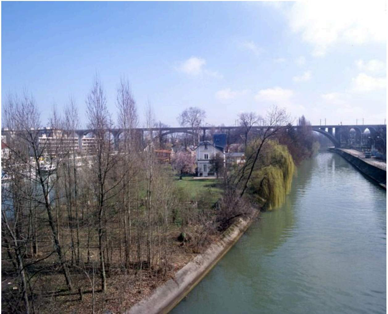
Vue depuis le pont de Nogent/Champigny vers le viaduc, au premier plan l'île des Loups.
