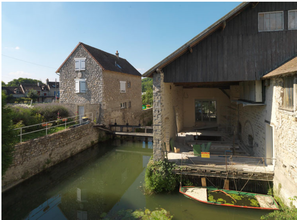
Vue extérieure. Vanne de barrage sur le Loing.
