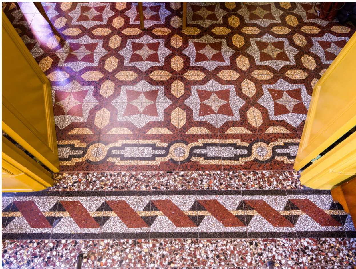
Carreaux de terrazzo du vestibule et de la salle à manger.
