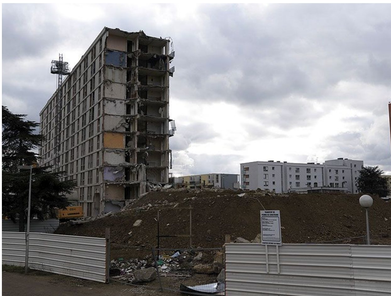
Orly, cité, rue Jean-Mermoz. Démolition d'un bâtiment du grand ensemble.
