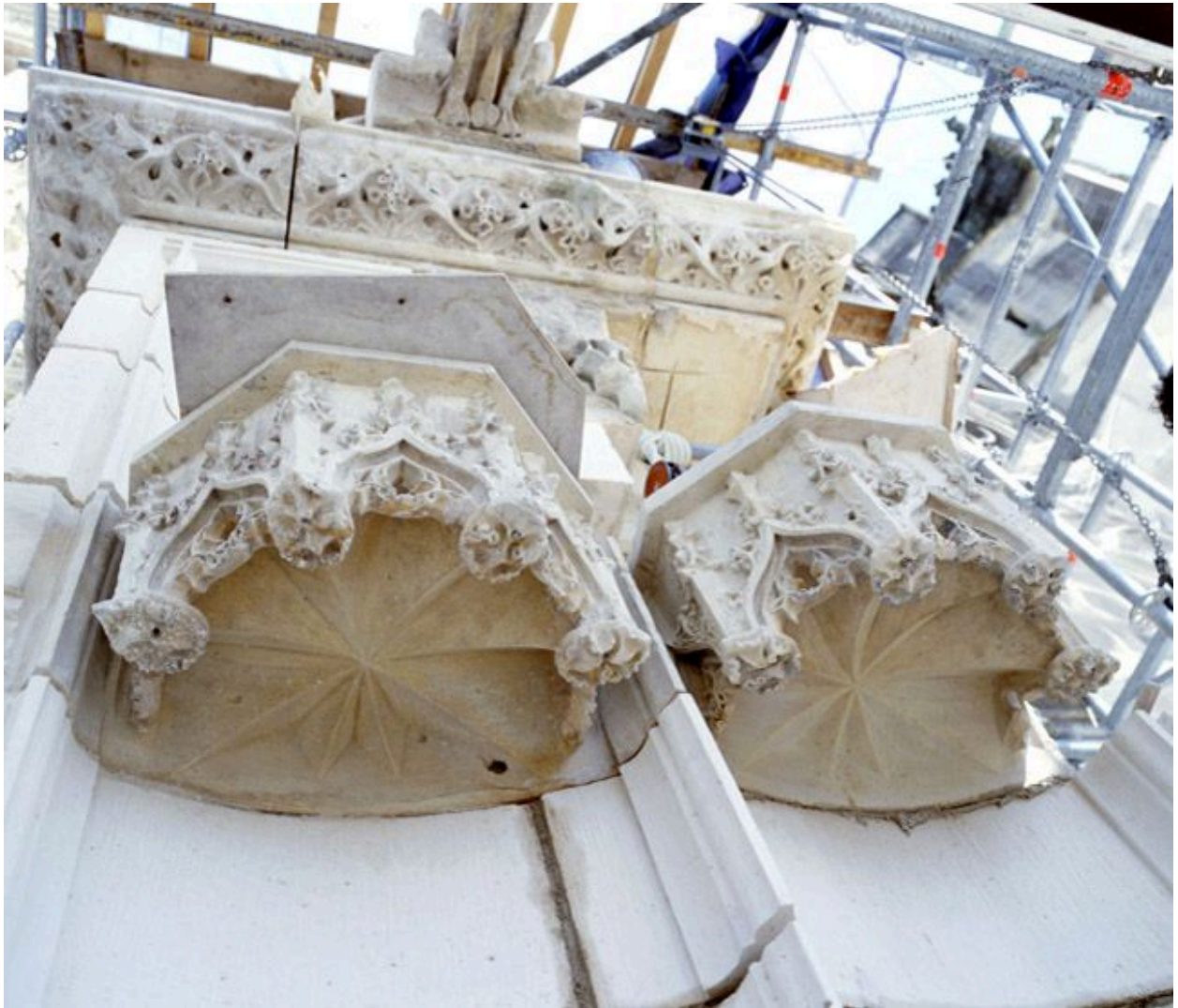
La façade occidentale : vue du chantier de restauration de la base de la tour nord (2008). Détail de la restauration des dais flamboyants.
