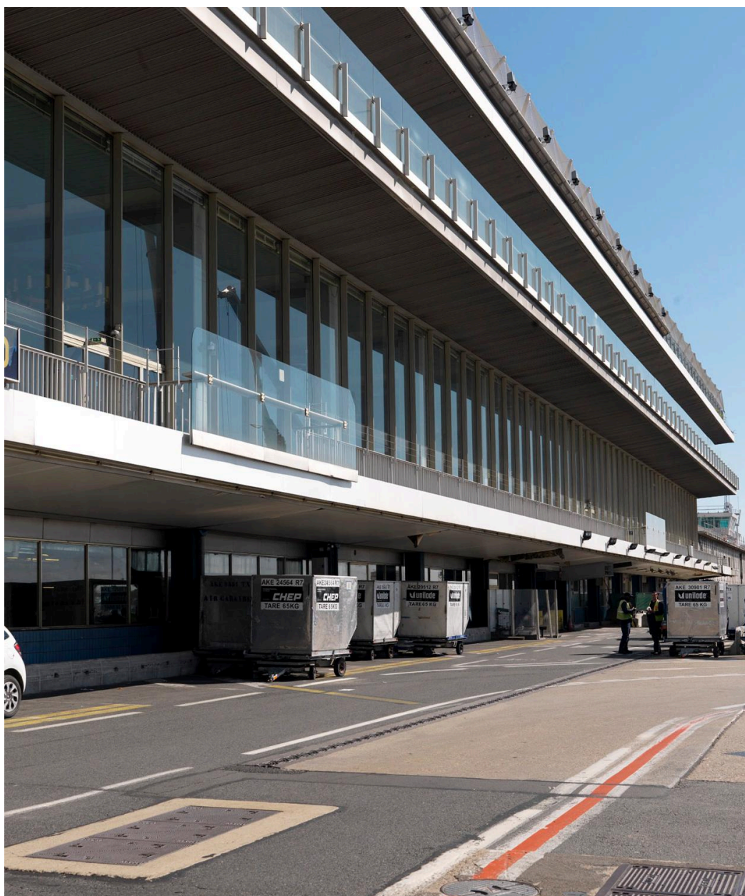
2018, Orly-Sud: le corps central vu depuis le sud ouest.
