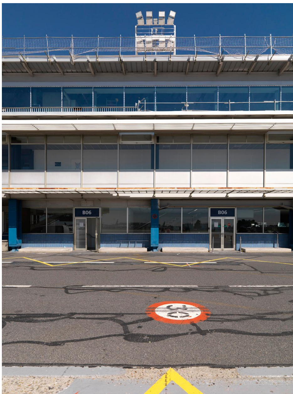
2018, Orly-Sud: les anciennes salles d'embarquement de la jetée ouest vues depuis le sud.
