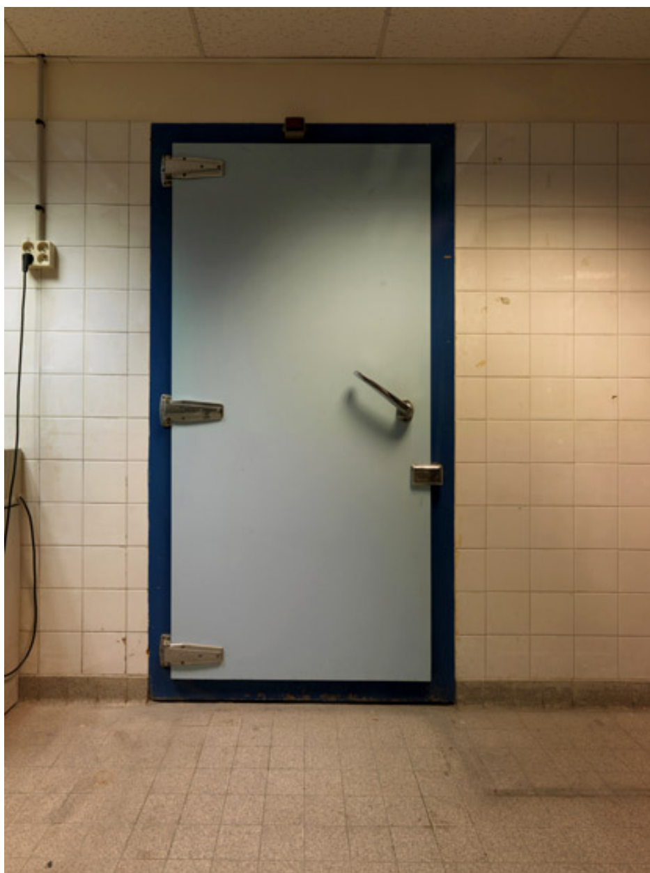
Porte de l'une des chambres froides des cuisines de la préfecture.
