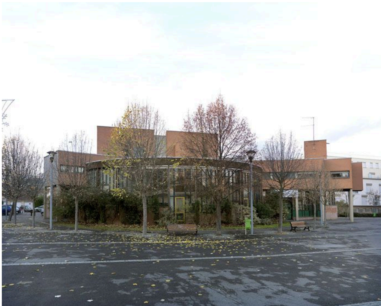
Maison de quartier Jacques-Brel, place André-Léonet. Vue de la maison de quartier depuis la place centrale. Renée Gailhoustet (architecte)
