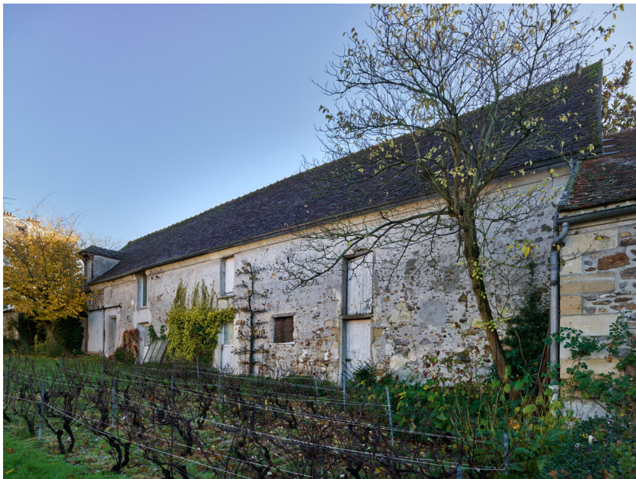
Vue de la dépendance depuis l'ouest.
