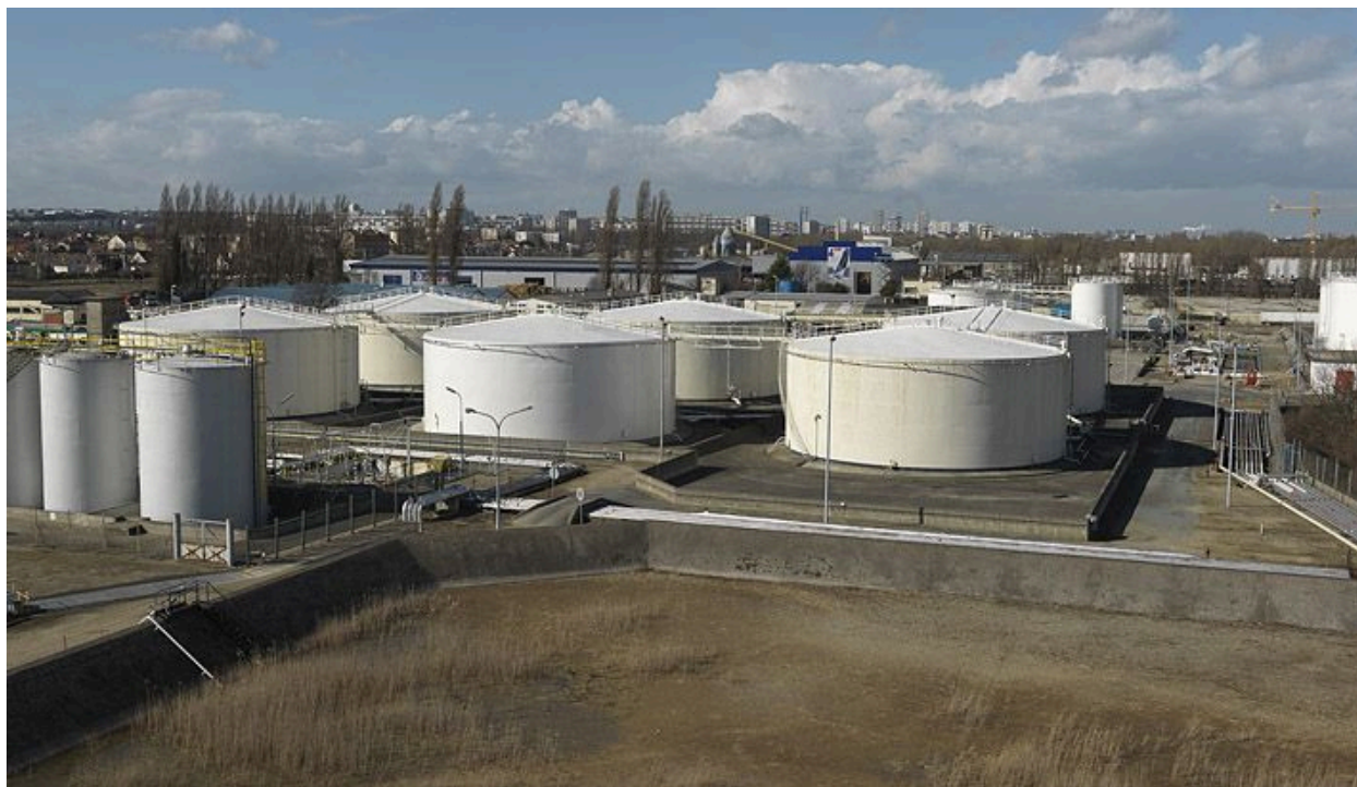
Villeneuve-le-Roi, dépôt pétrolier. Vue générale du site.
