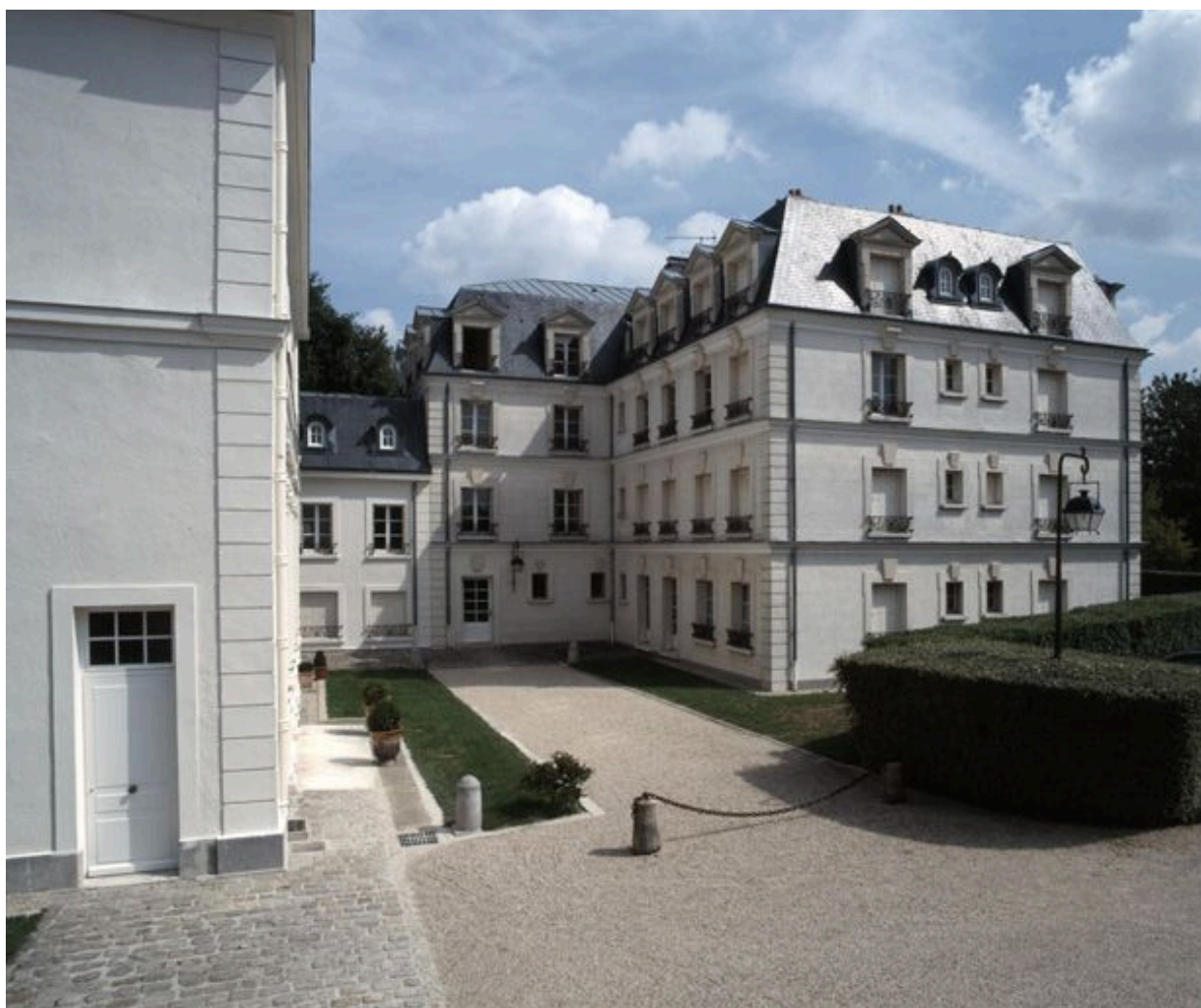
Vue d'ensemble du corps de bâtiment construit à l'arrière du château.
