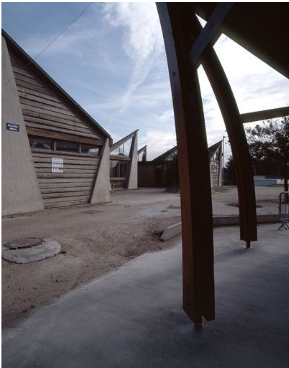
Autre vue des mêmes bâtiments (situés près de l'accès au port).
