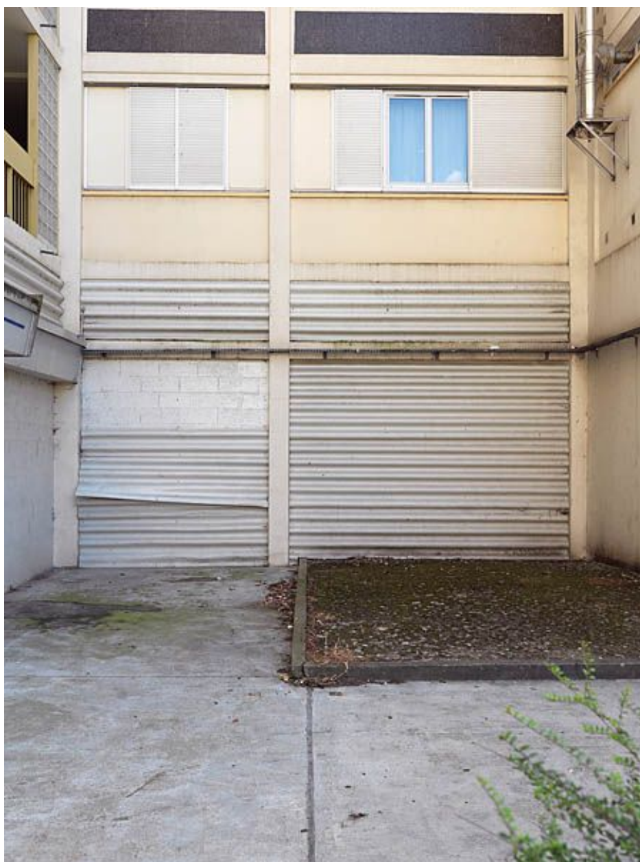
Cité dite Résidence Saint-Hubert. Mise en oeuvre des rez-de-chaussée : mur en parpaing de béton recouvert d'un rideau de tôle plastique ondulée.
