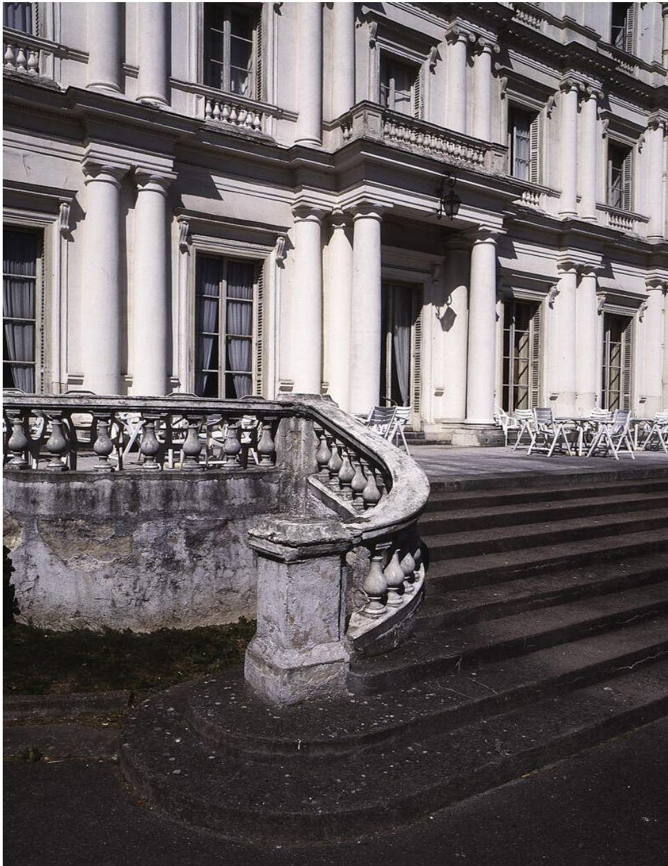
La façade sur le parc : détail du perron donnant accès au château.
