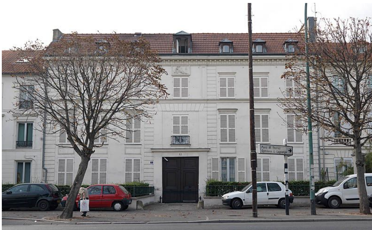
Thiais, maison de maître, 5 boulevard de Stalingrad. Vue d'ensemble.
