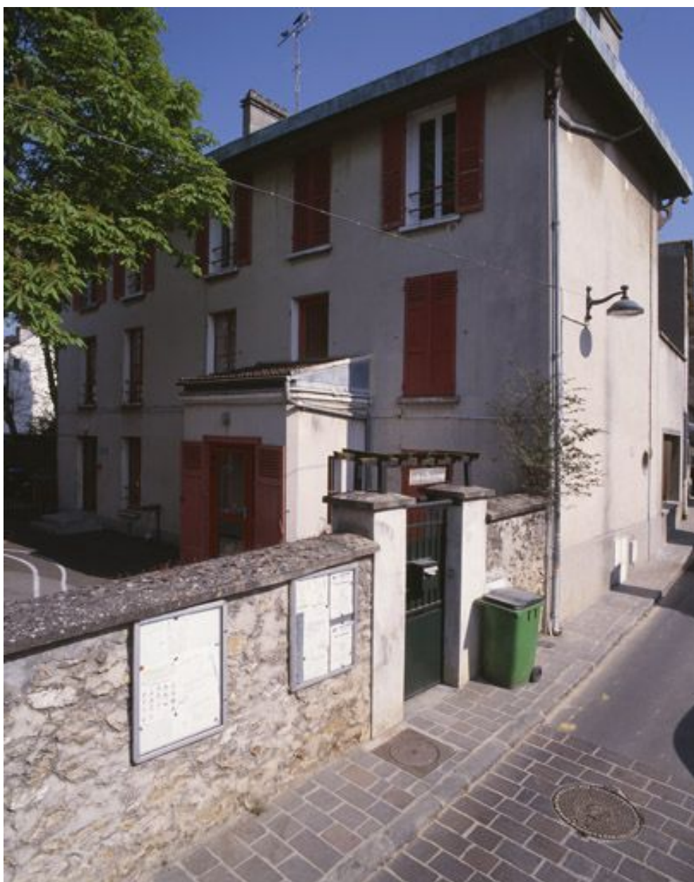
Vue du bâtiment contenant les logements des instituteurs.
