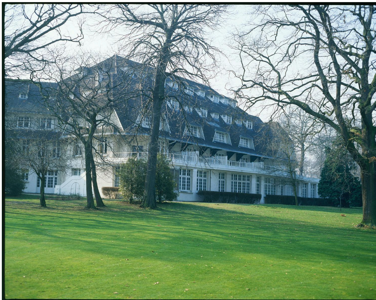
Vue de la façade postérieure du Club-House.
