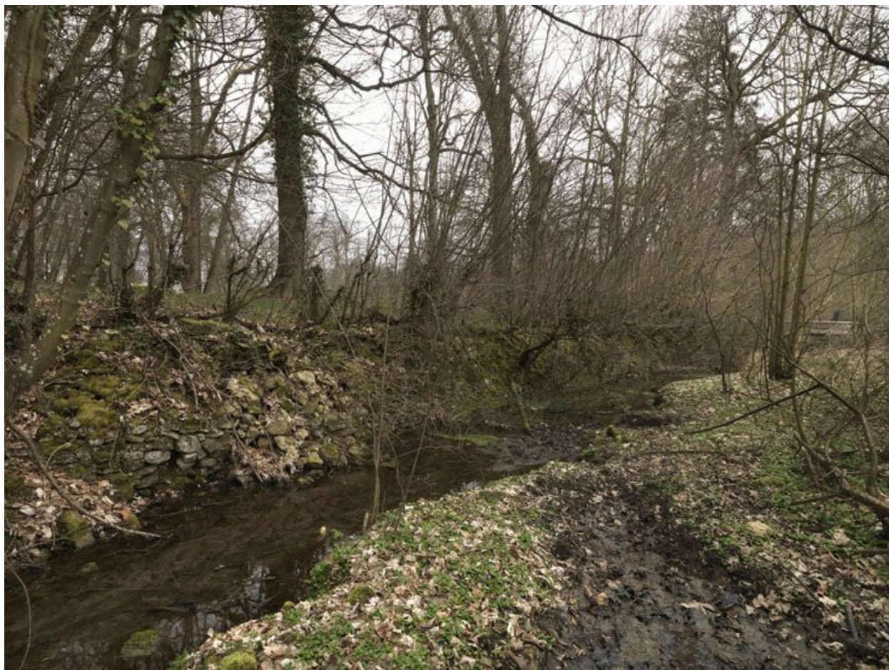
Vue générale du déversoir.
