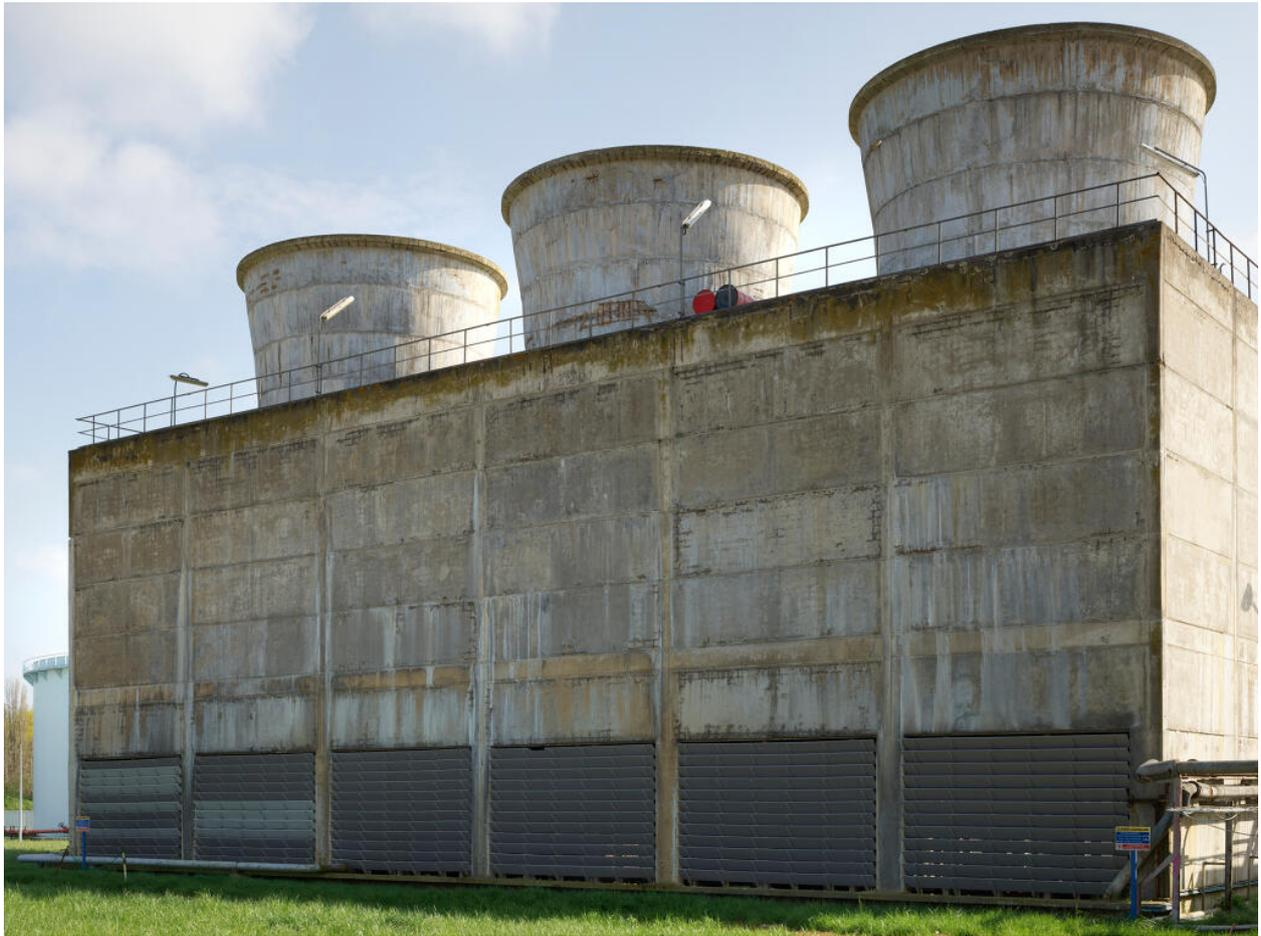
Zone du traitement des eaux (Unité 420). Tour aéroréfrigérante "SCAM", utilisée pour refroidir les eaux procédé pour le fonctionnement des Unités Ouest.
