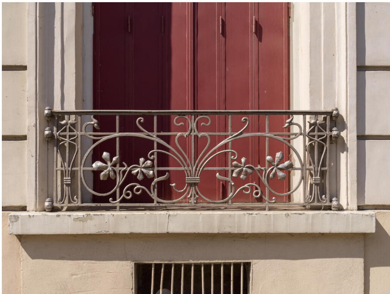
Détail d'un garde-corps de la partie est de la façade.
