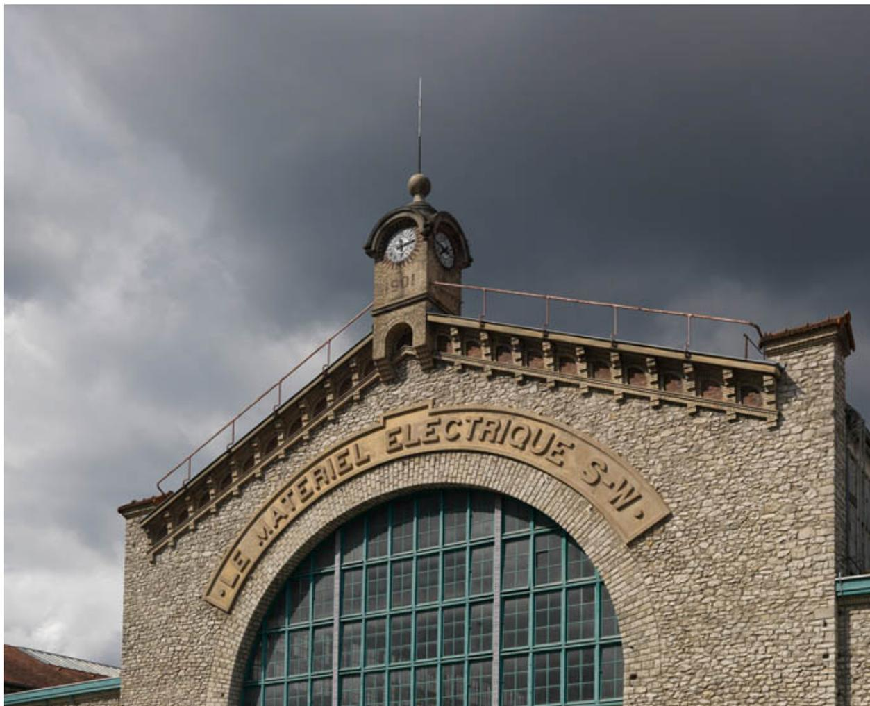
Vue extérieure de l'usine côté voie ferrée. La nef centrale. Le pignon monumental, ouvert d'une large baie cintrée, est couronné d'une double corniche rampante alternant corbeaux et arcades en briques brunes de Montereau
