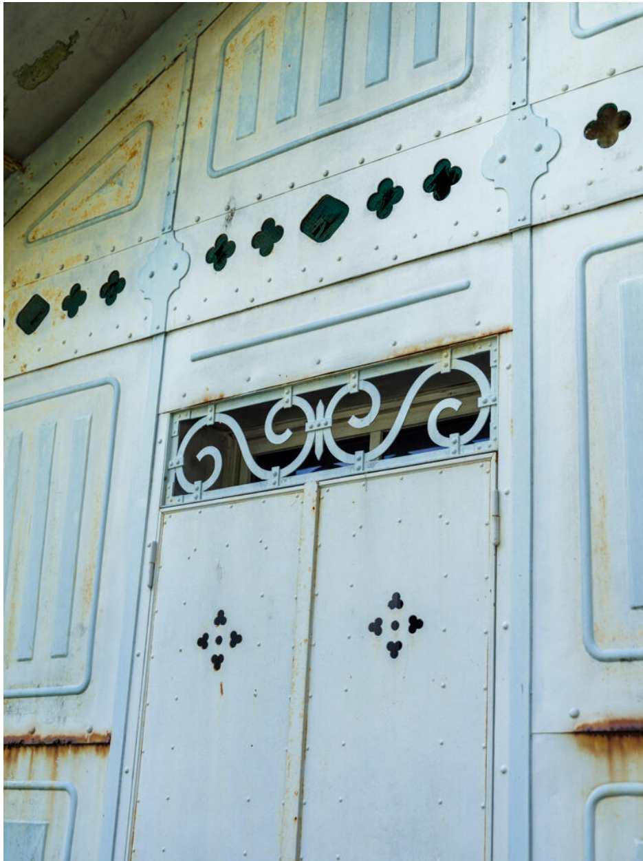
Détail d'une porte fenêtre en façade latérale.
