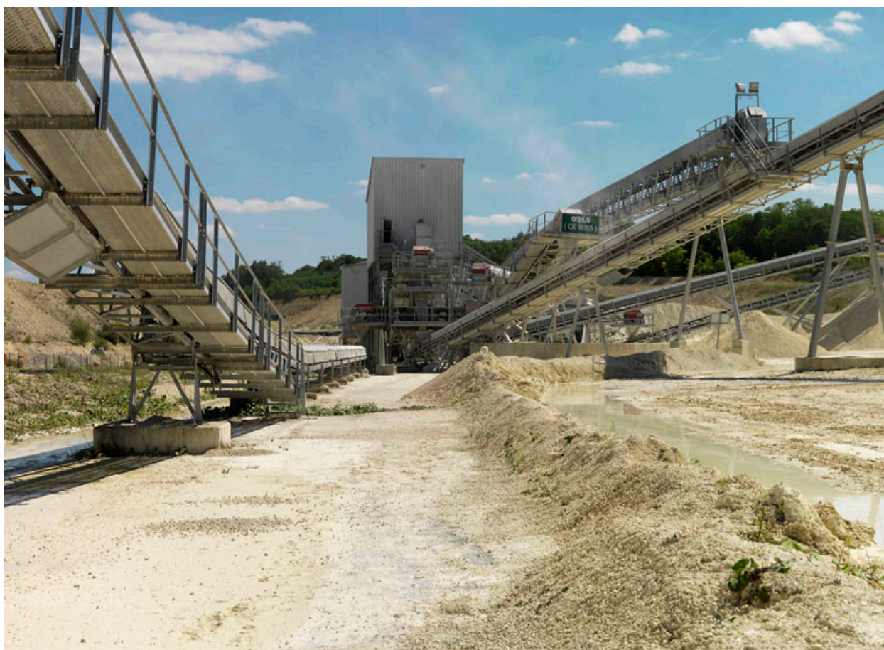
Plateforme - installation secondaire.
