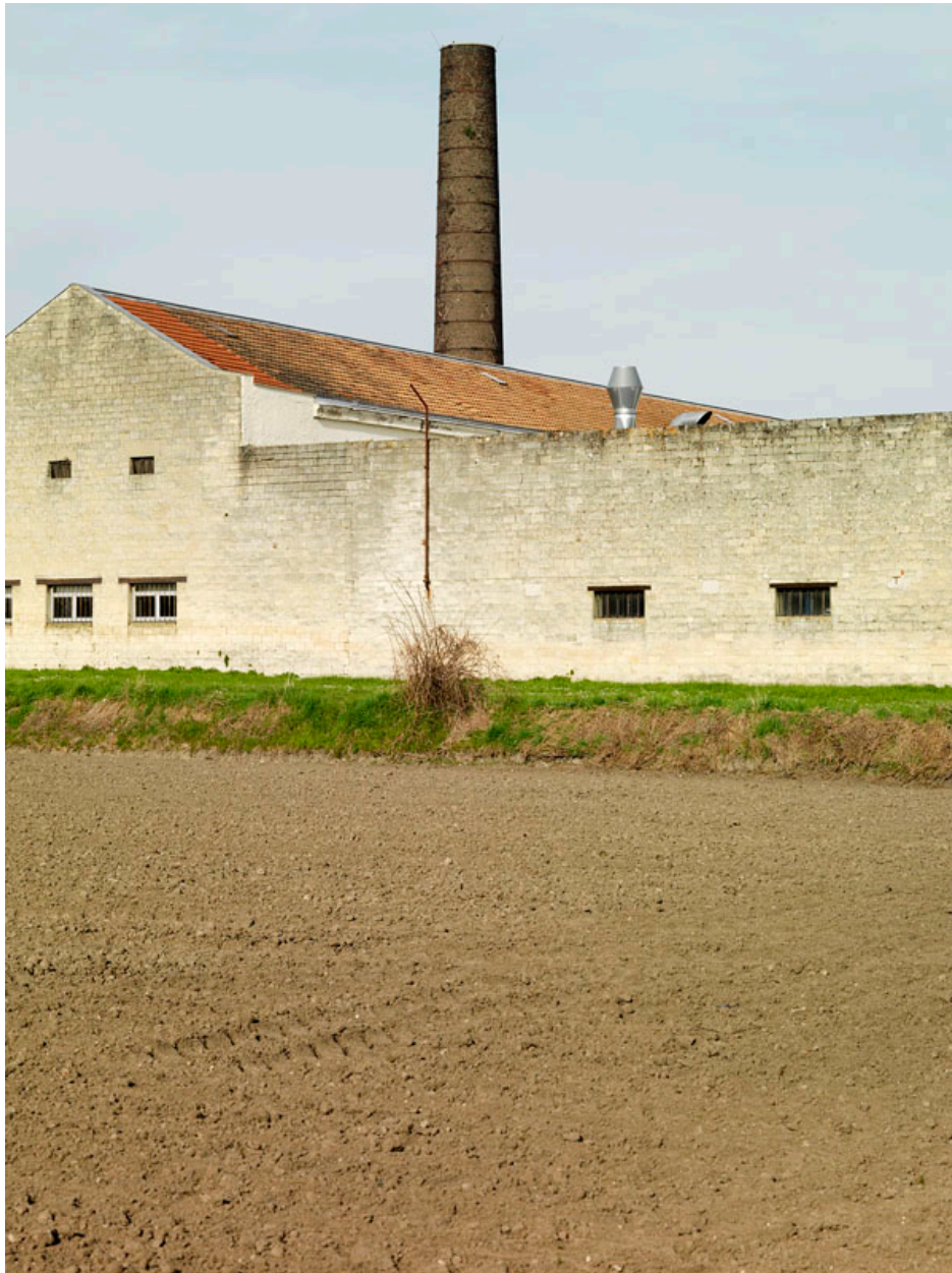
Persan. Ancienne usine de caoutchouc "The India Rubber", actuellement usine Hutchinson. Cheminée.
