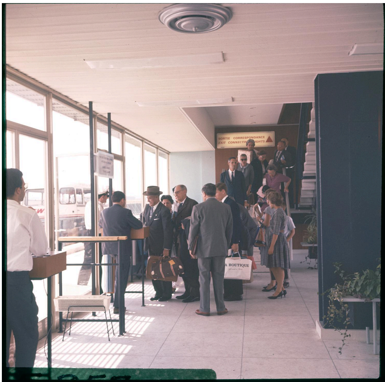
1961, salle d'embarquement, rez-de-chaussée coté piste.
