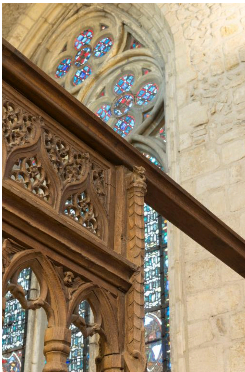
Détail des arcatures et de la frise ajourée qui les surmonte.
