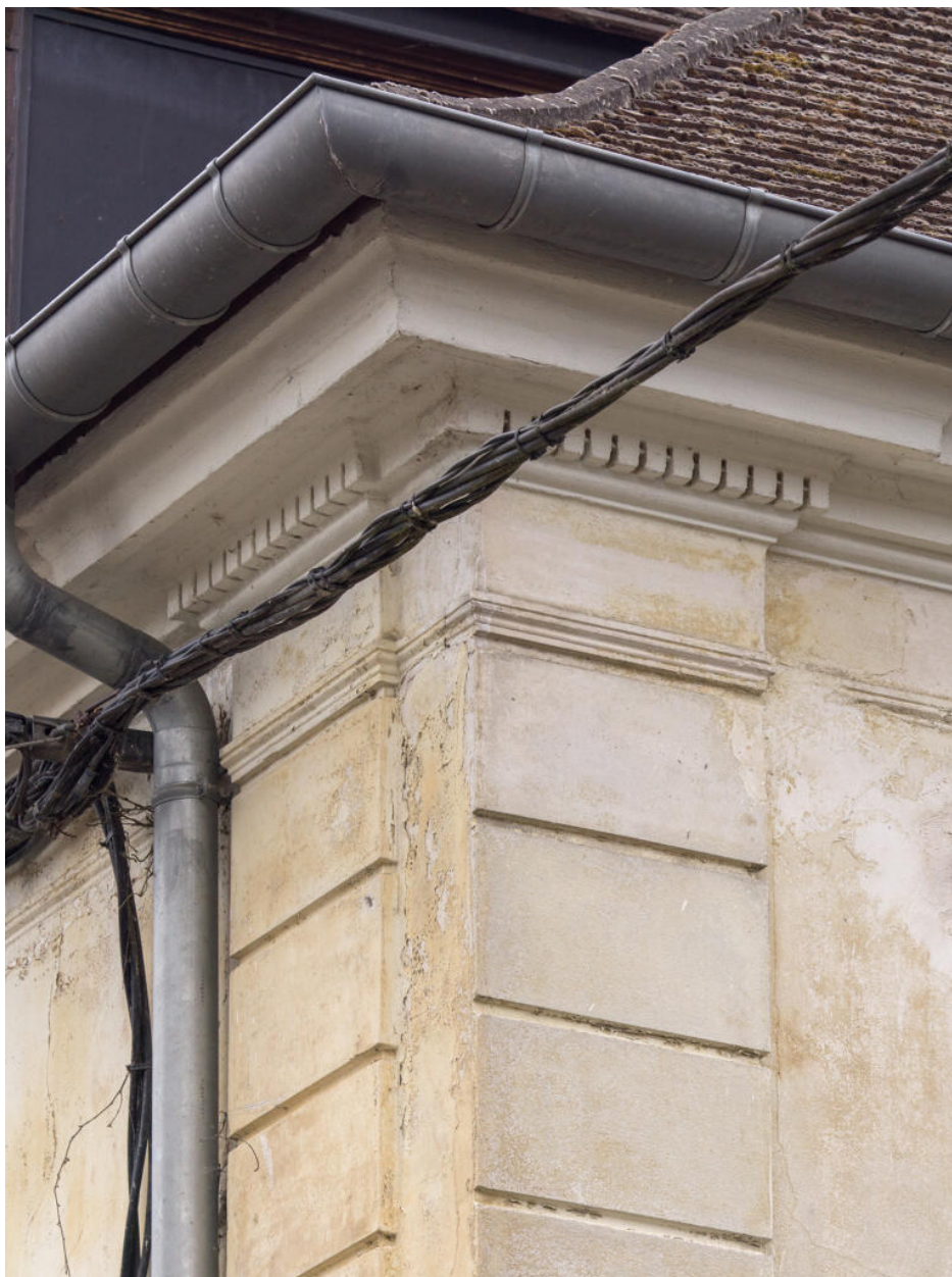
Vue de détail du décor de la partie haute de la chaîne d'angle nord.
