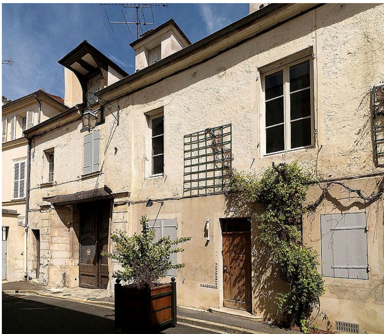
Vue générale de l'élévation sur rue.
