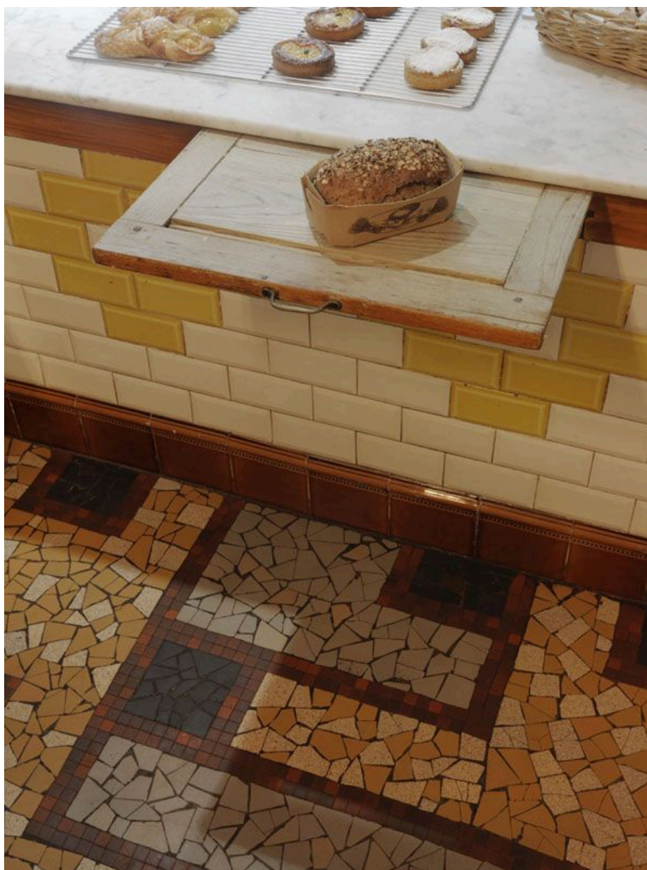
Détail du carrelage de sol en carreaux brisés et pose pain amovible en bois.
