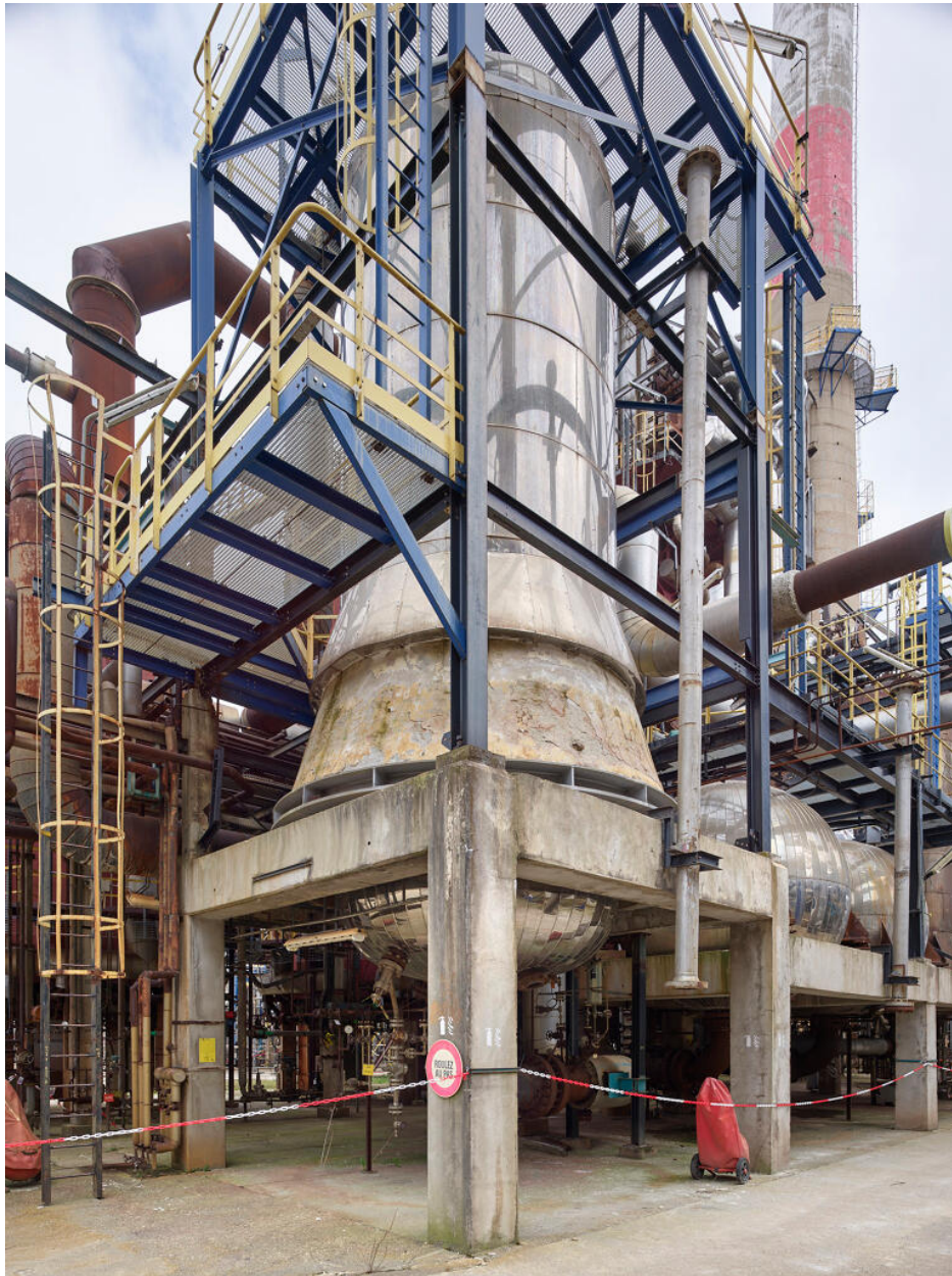
Unités Ouest - Reformeur catalytique (Unité 642). Réacteurs 642 D8 (au premier plan) pour la production d'essence à haut indice d'octane. Réacteurs D6 et D7 en arrière plan.
