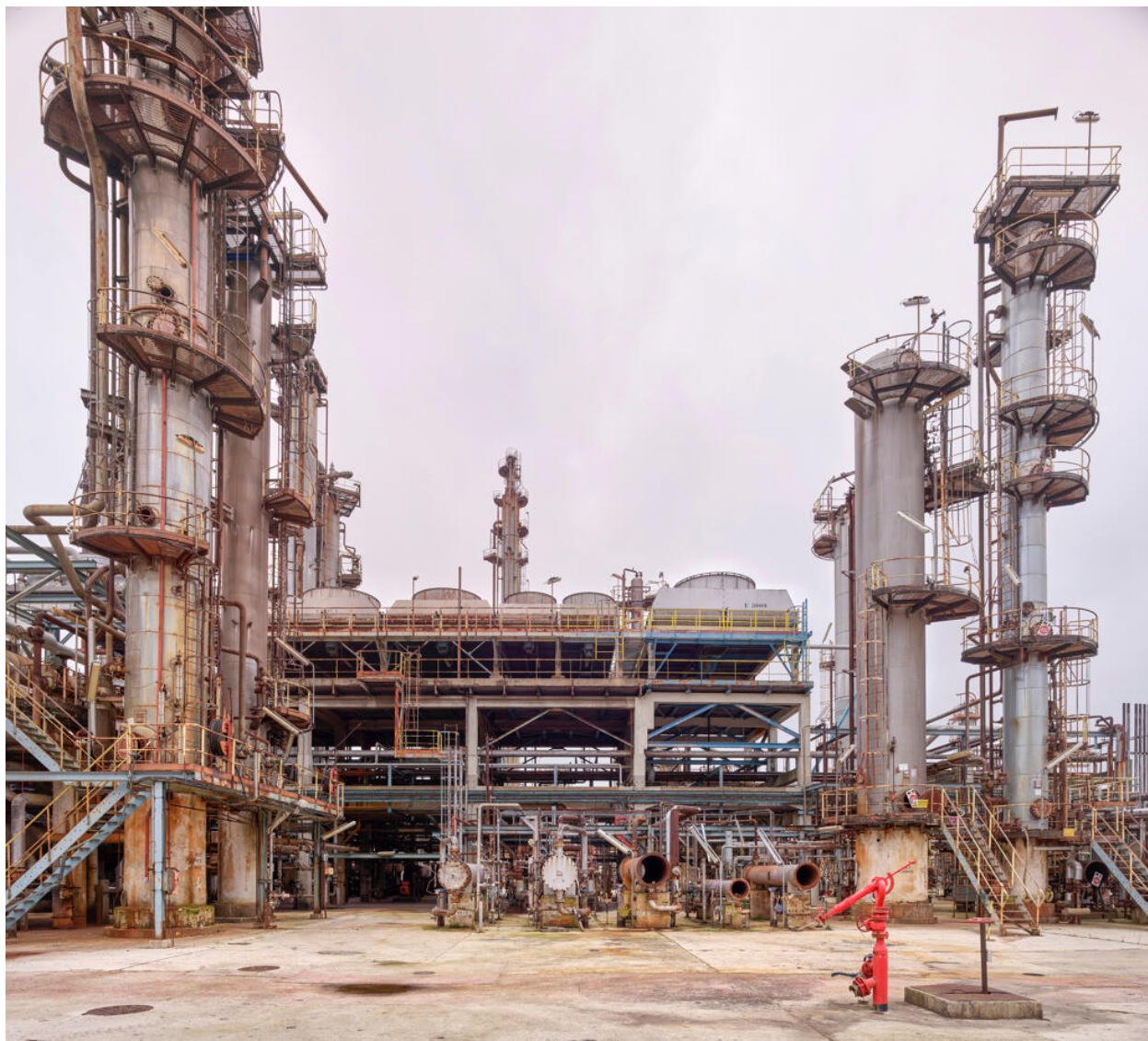
Unités Est - FCC (Unité 651). Absorbeurs. Première séparation gaz-essence.
