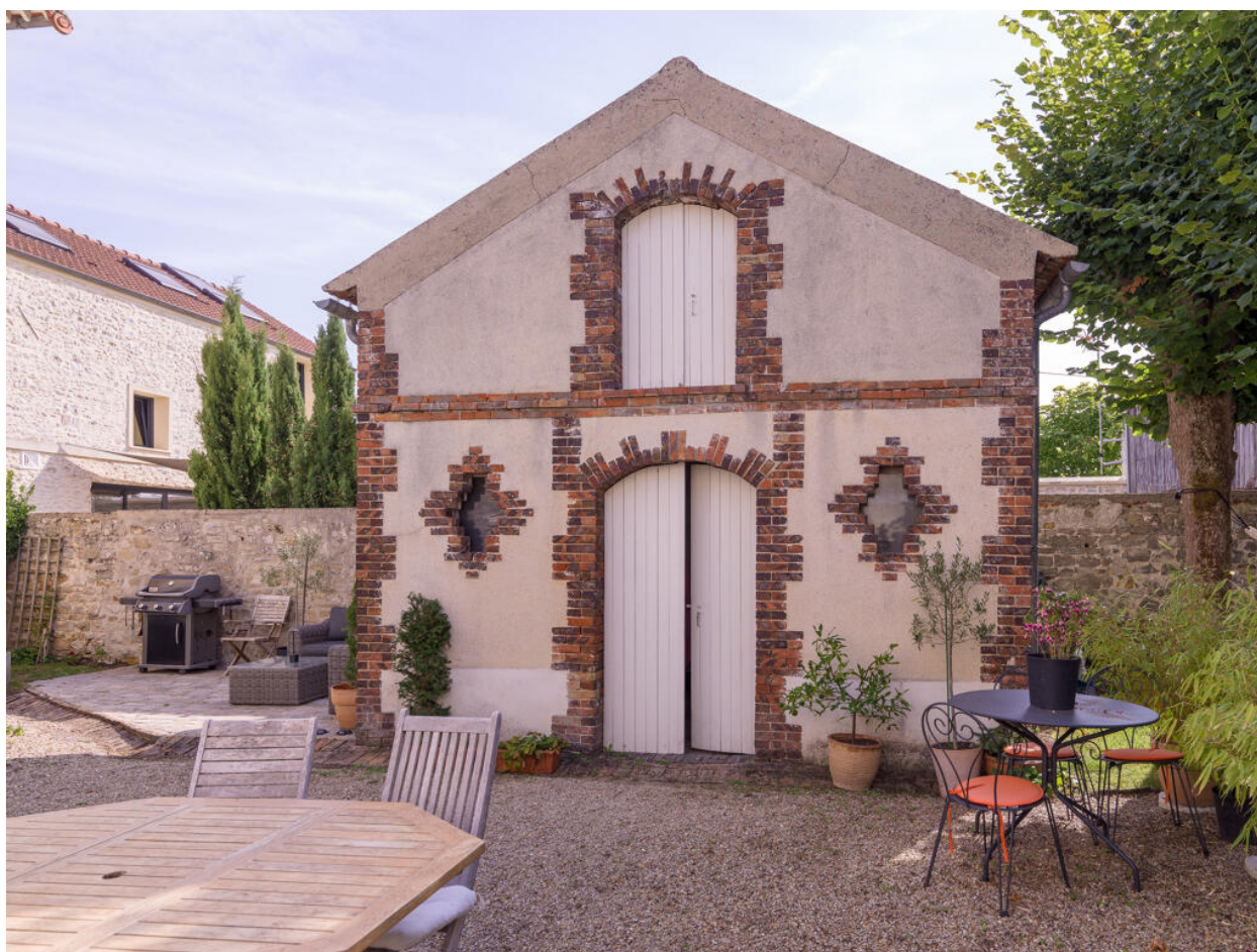
Vue de la façade ouest de l'ancienne écurie.
