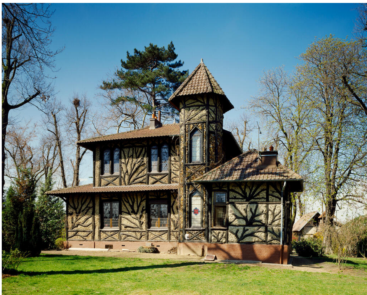
La façade postérieure
