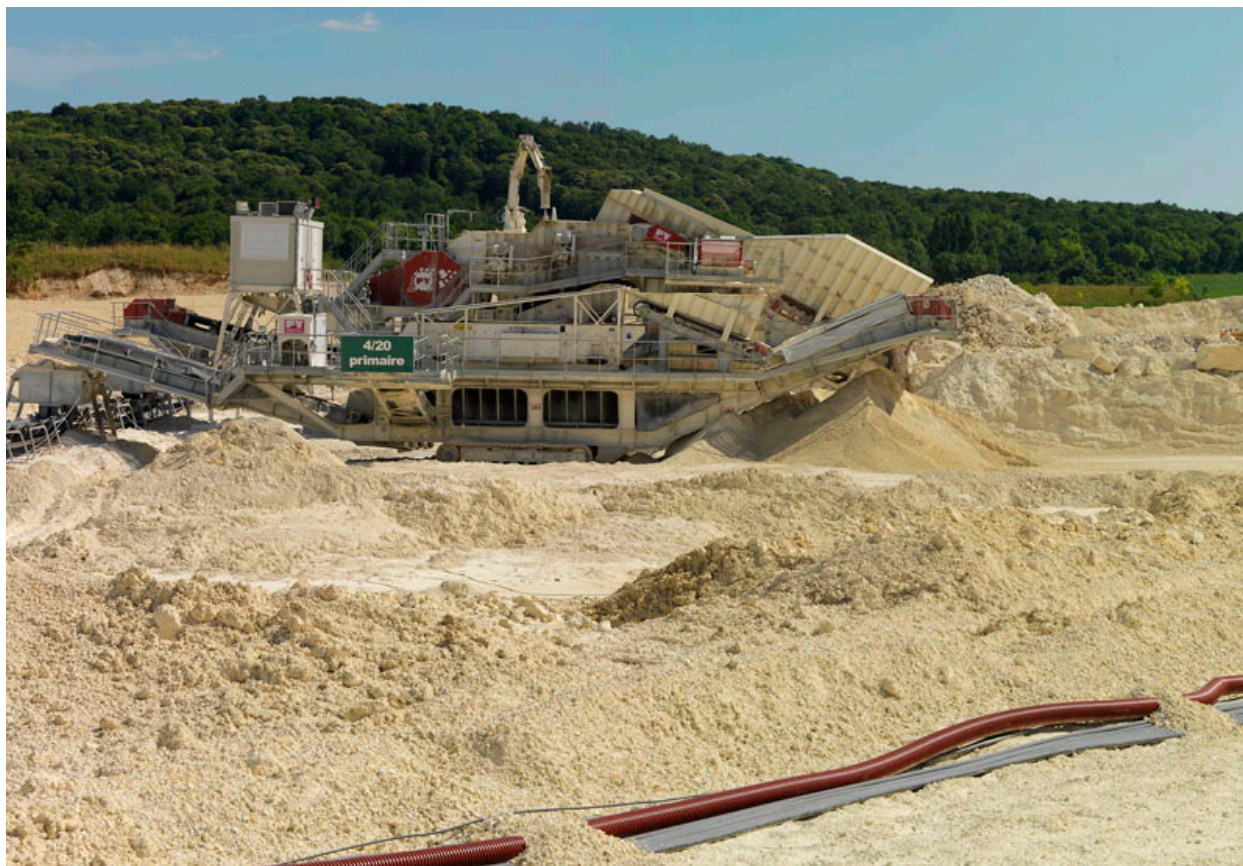
Installation primaire. Groupe mobile primaire équipé d'un concasseur a machoires Sandvik CJ612
