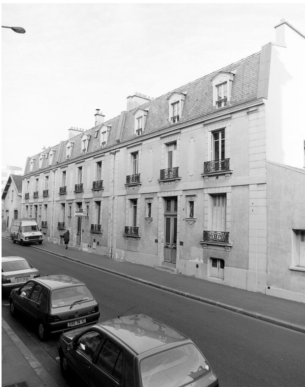
Rue Mathilde-Girault, l'ensemble des maisons en série construites vers 1880. Maison d'Antonin Raynaud, puis maison de la Résidence Sociale
