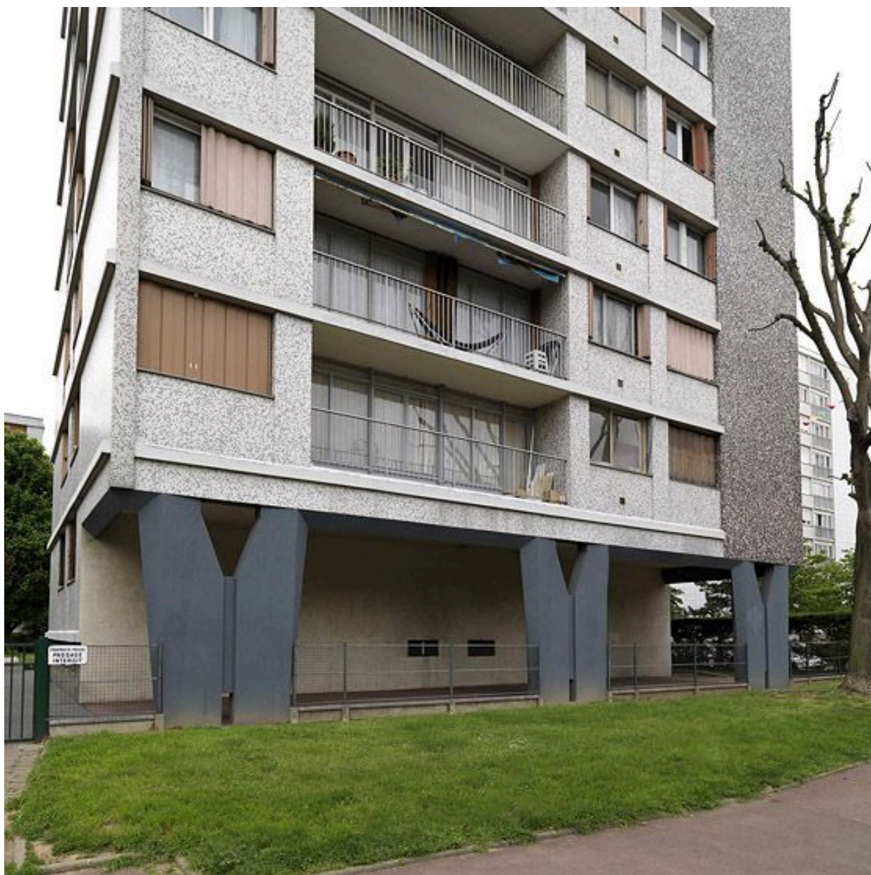
Vitry-sur-Seine, cité, 25-29 rue Camille-Blanc. Détail des pilotis de cet ensemble résidentiel construit en 1967.
