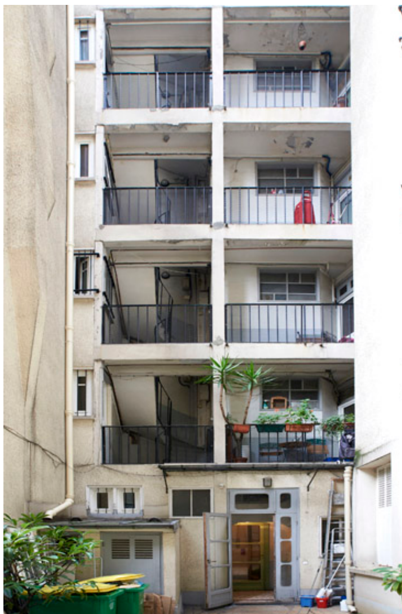
Vue de la façade sur cour du n°1.
