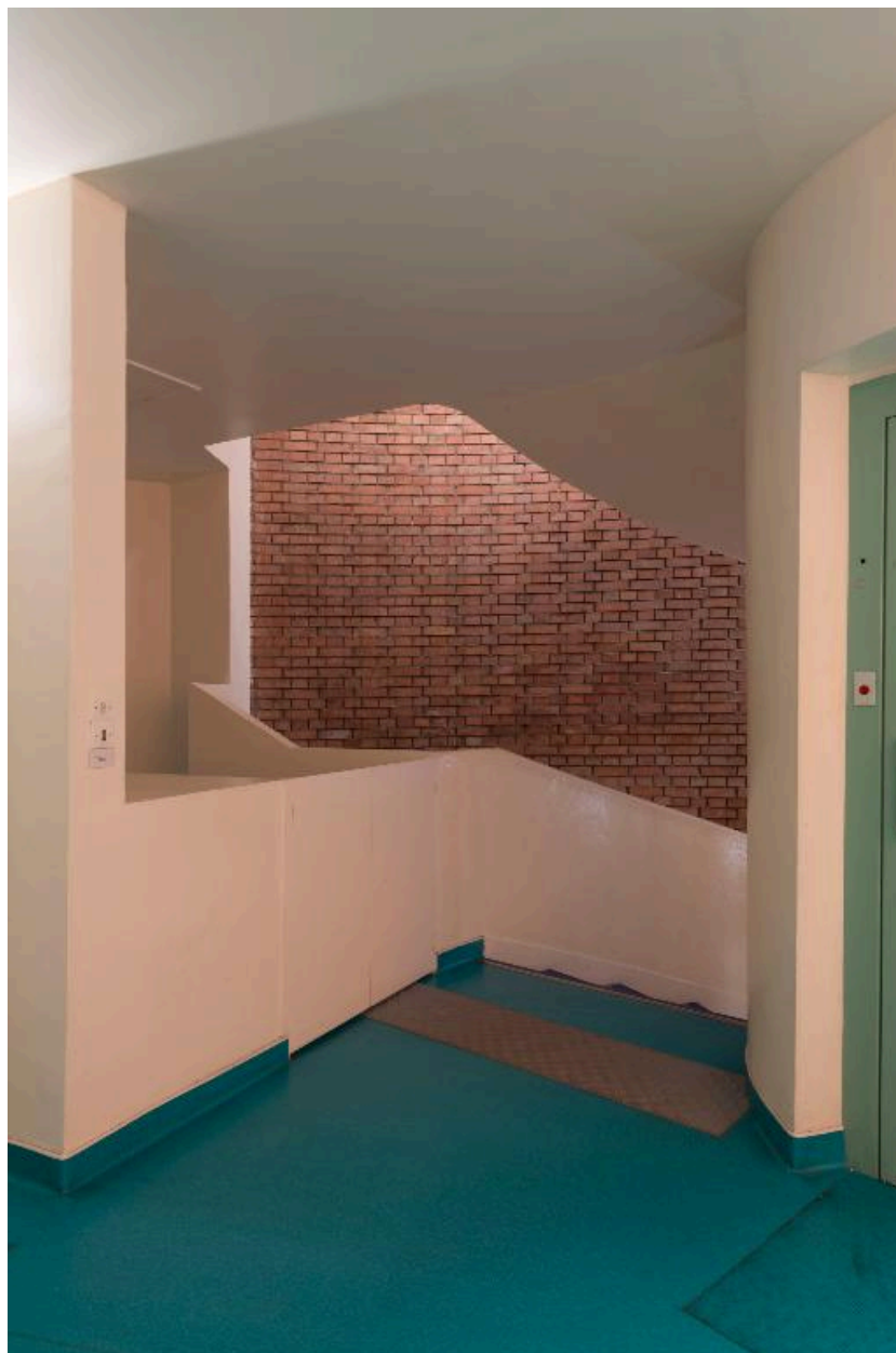
Vue du départ de l'escalier en vis au premier étage.
