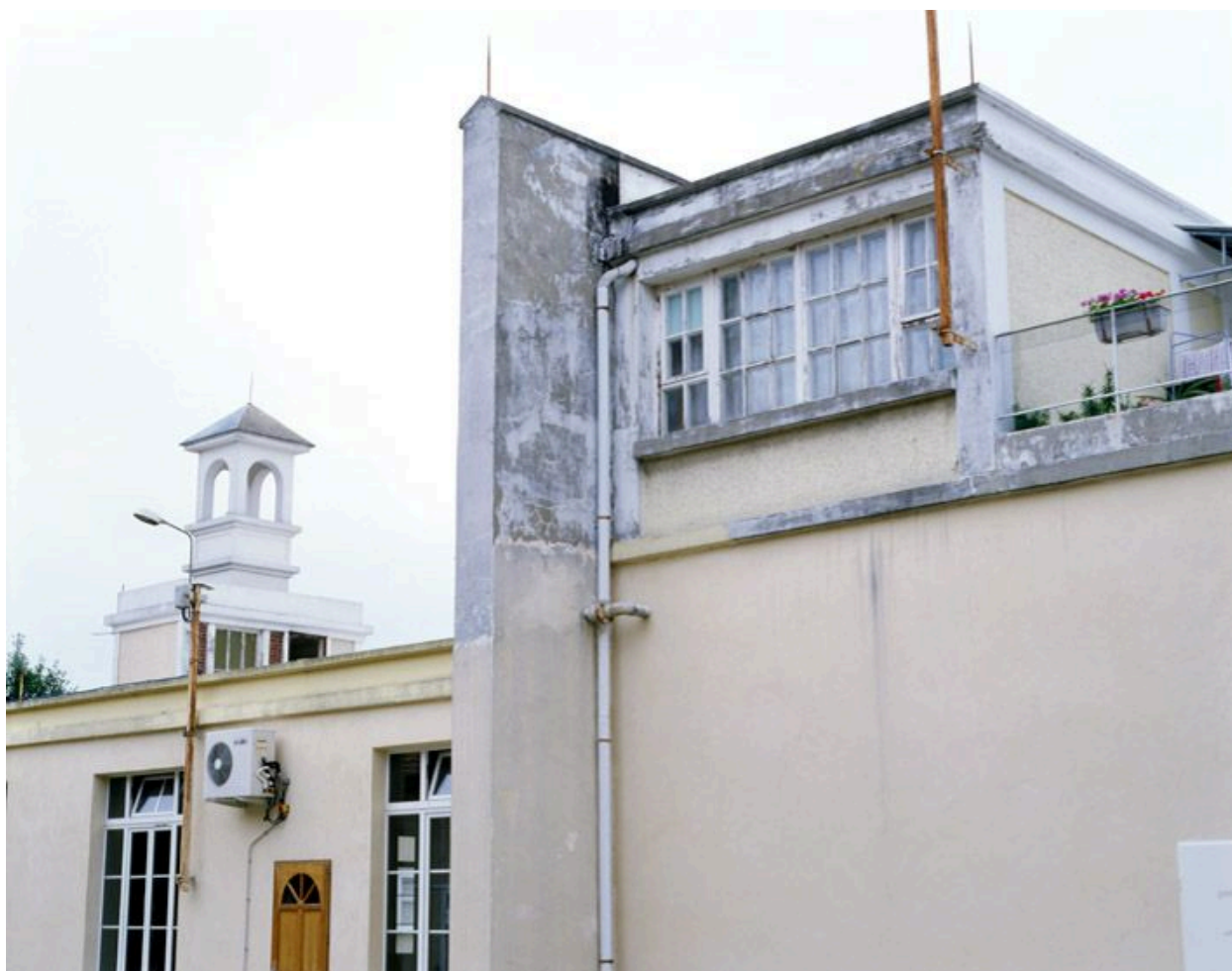
Détail de la façade ouest du bâtiment administratif, avec vue du clocheton.
