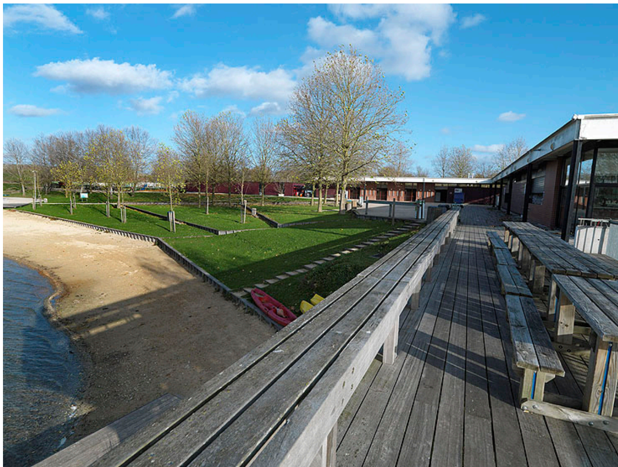
Le bâtiment d'accès à la plage de Torcy : vue prise de l'ouest, depuis la terrasse.
