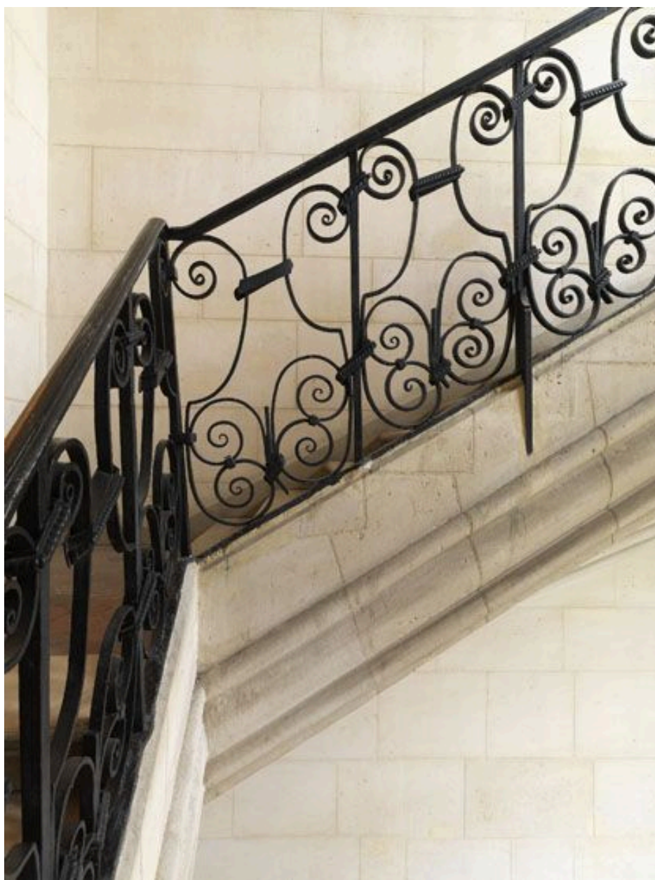
Détail des panneaux de balustres.
