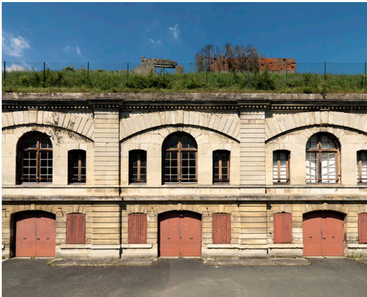
Vue de trois travées de la façade sud de la caserne.
