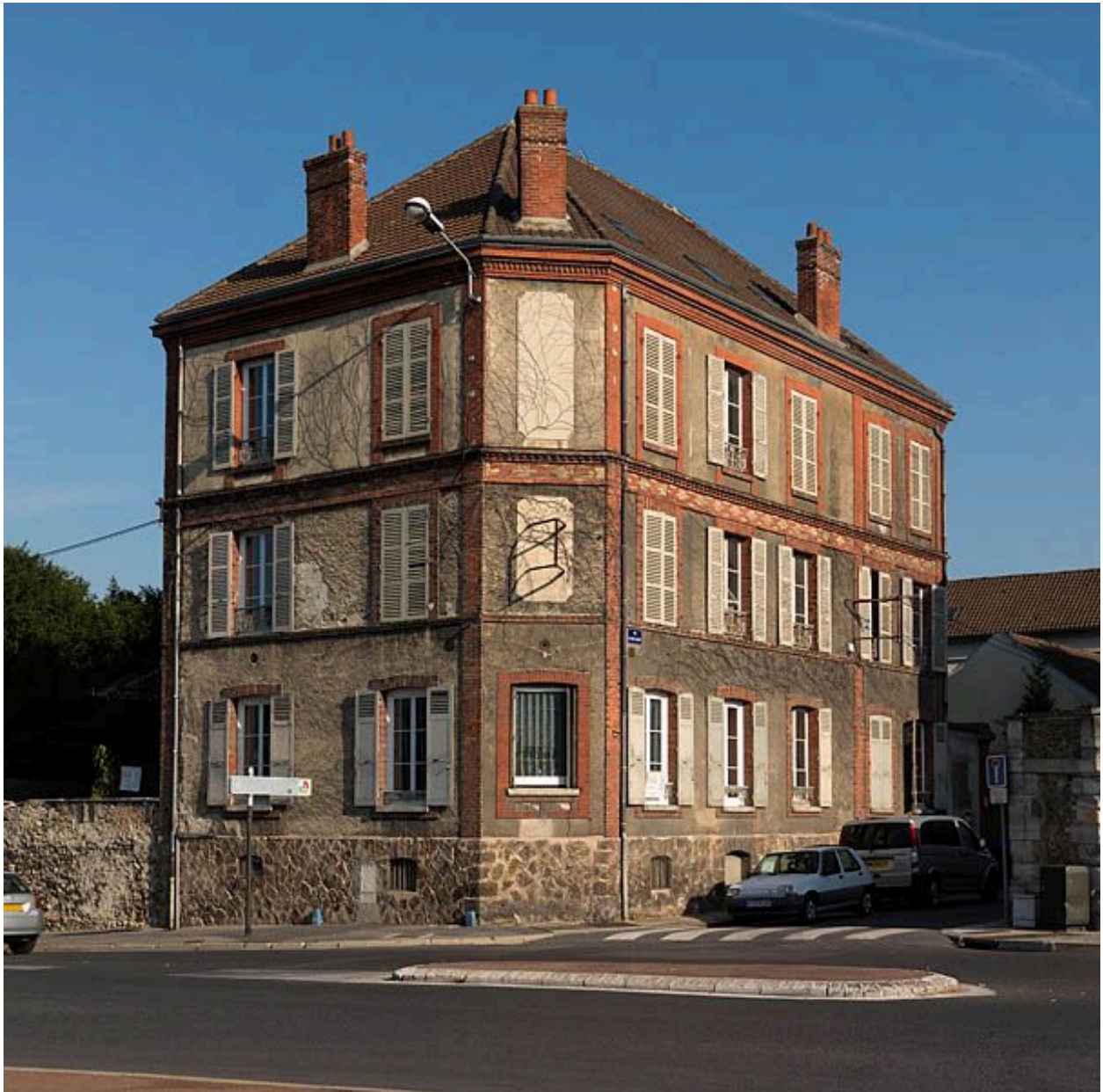
Vue d'ensemble, depuis le boulevard Jean-Rose.
