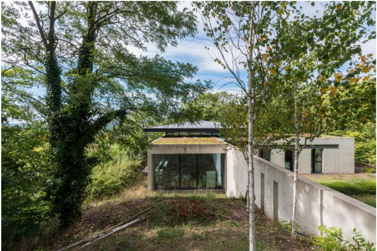
Vue de l'espace de l'atelier (extérieur)
