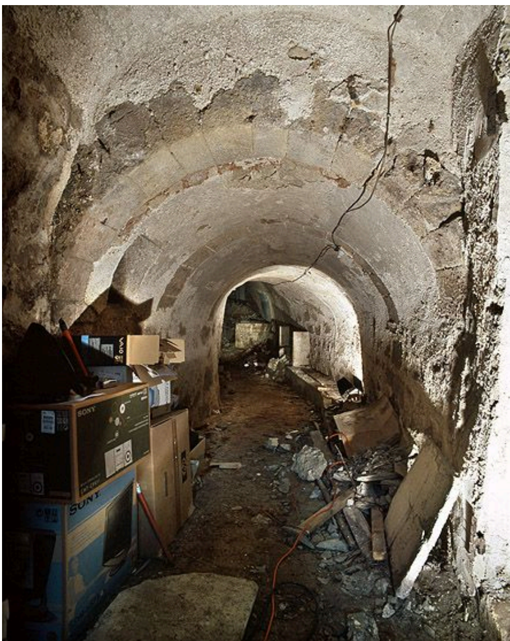
Le cellier, vue d'ensemble.
