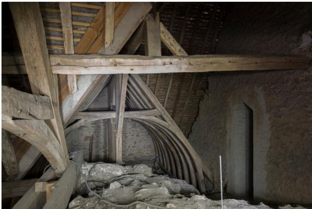
Charpente du chœur : vue d'ensemble, depuis l'entrée par le clocher.
