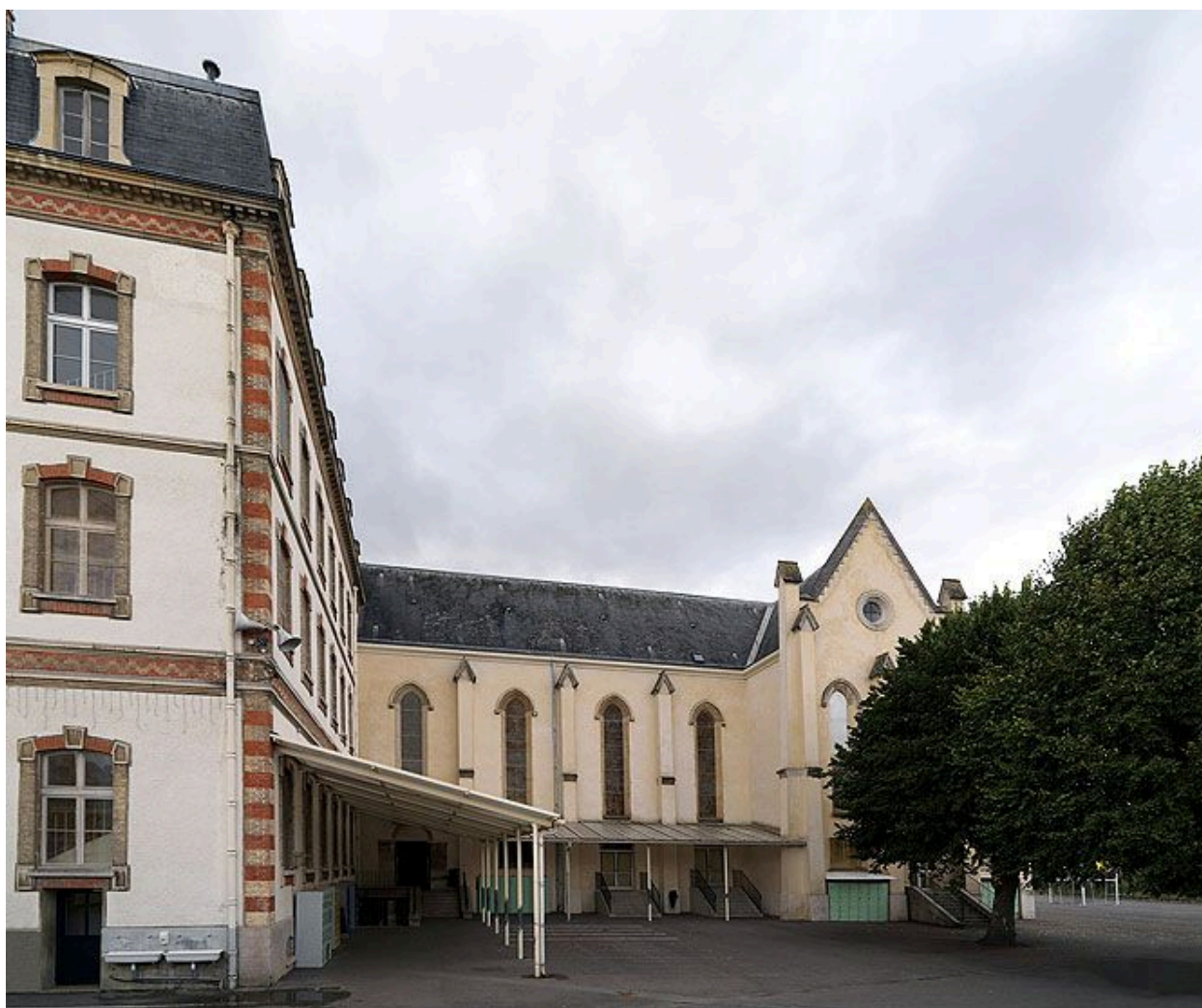
l'angle du corps de bâtiment principal (1887) et la chapelle, vus de l'est.
