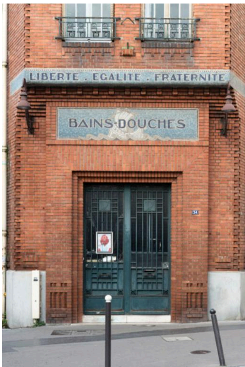
Détail de l'inscription "bains-douches" et du blason de la Ville de Paris, au-dessus de l'entrée de l'établissement.
